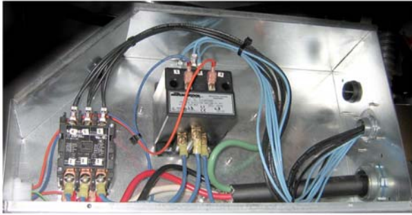
Ляв и десен изглед на компонентите на кутията на механичен контактор.
